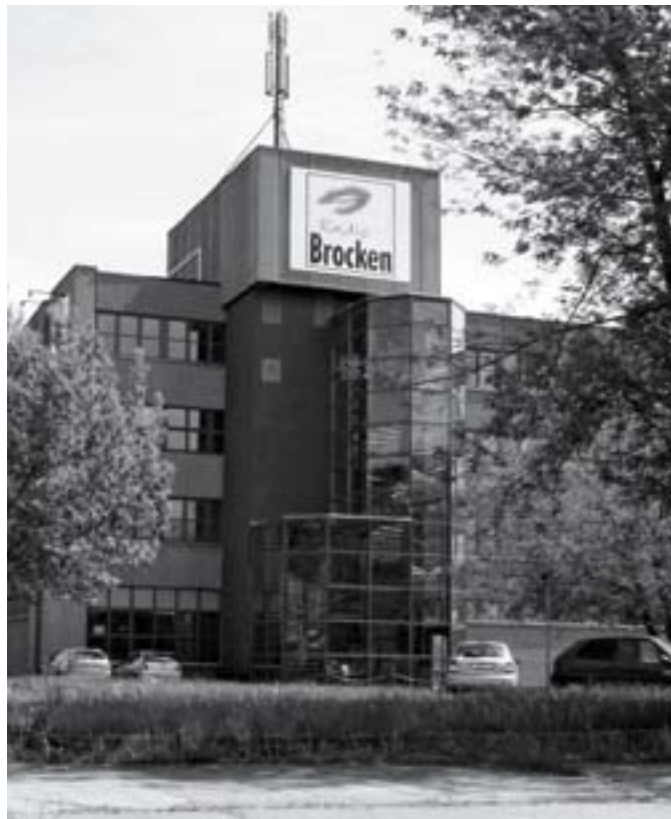
Altes Funkhaus von Radio Brocken am Rand der Stadt Halle
