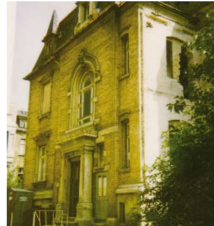
Dienstsitz Reichardtstraße 9 vor der Sanierung
